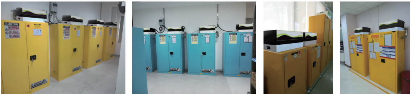
Chemtrap Midcap: 케미컬 보관 캐비닛에 널리 사용되는 여과시스템
